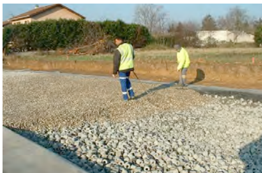
Ouvrages enterrés ou techniques: Structure sous chaussée en cours de réalisation
