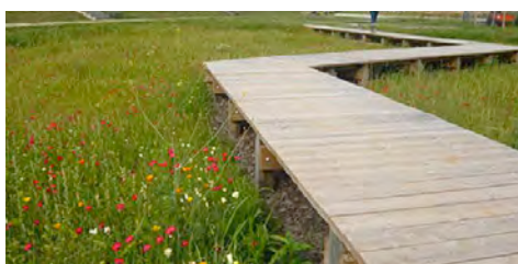
Ouvrage vert à ciel ouvert : Espaces inondables à destination d'usage à Metz (57)
