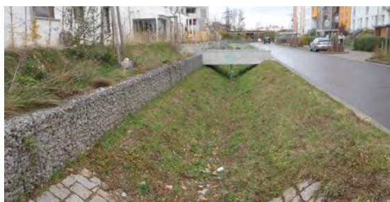
Ouvrage vert à ciel ouvert - Noue enherbée simple - Fribourg (éco quartier) Vauban
